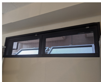
▲定期的な換気(窓/ドア全 4 箇所を開放)
